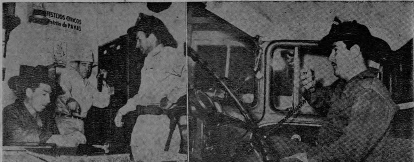
El Comandante del Cuerpo de Bomberos de Costa Rica, Mayor Hernández, se comunica en una llamada de emergencia con la Subestación de Barrio Luján usando el nuevo y moderno equipo de radio. Con él aparecen el Cabo Alvaro Corrales y el Sargento Gorgonio Mora, dos de los viejos bomberos de Costa Rica. En la otra gráfica se aprecia a un bombero recibiendo una llamada de radio en la propia cabina de una bomba. Todas las bombas usan ahora radio como las Patrullas
